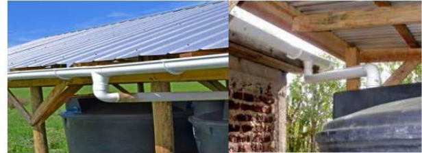
Imagen 1. Canaletas y cubiertas para el mejor aprovechamiento del agua de lluvia. Fuente: Mario Castillo 3 .
